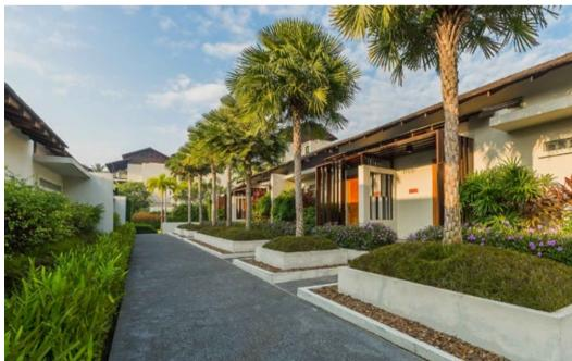
การทำชายคางองอาคารให้ยื่นยาวก็เพื่อให้ เหมะสมกับสภาพภูมิอากาศที่มีฝนตกชุก อันเป็น เอกลักษณ์เด่นของงานสถาปัตยกรรมแบบเมืองร้อน ส่วนพื้นด้านล่างเลือกโรยหินกรวดสำหรับรองรับ น้ำฝนที่ไหลลงมาผ่านชายคา เพื่อไม่ให้กระเซ็นเข้ามา สร้างความเปรอะเปื้อนในอาคารหลังนี้
